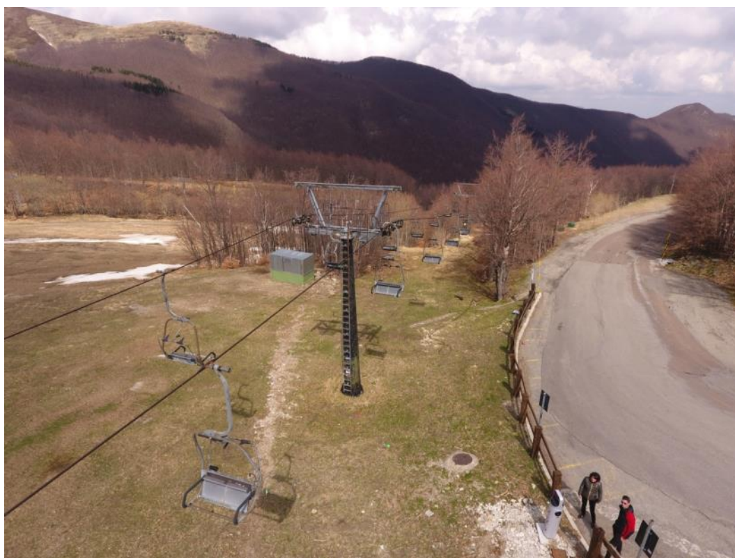
Vista aerea – seggiovia bisposto esistente
